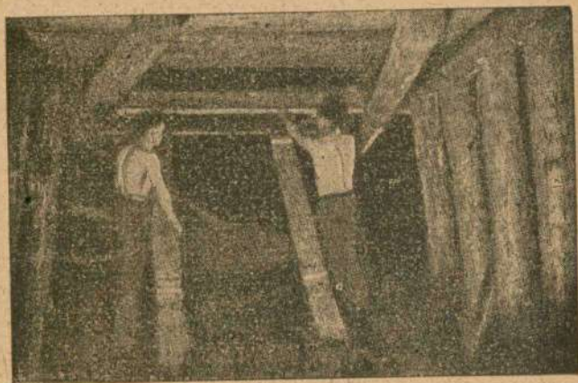
W chodniku kopalni węgla
